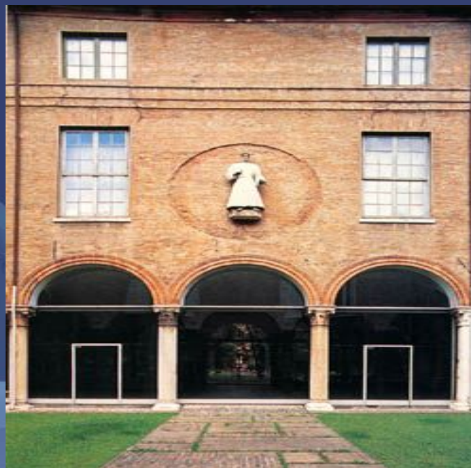
Palazzo Renata di Francia. Cortile interno con statua di Alberto d'Este
